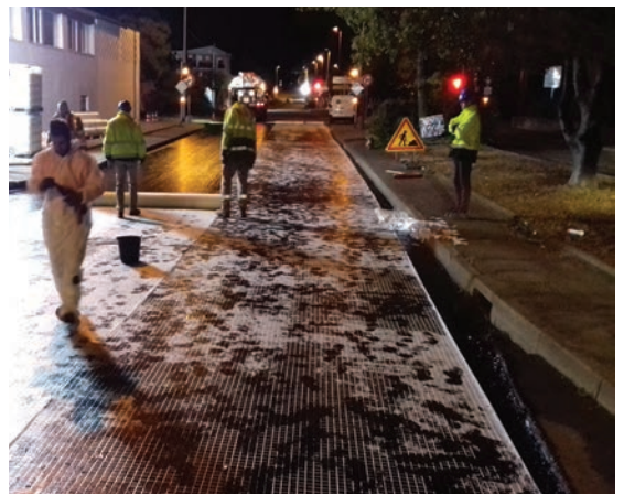
RN7 : Chantier expérimental d'enrobés à Roussillon permettant le renforcement de la structure de la chaussée
