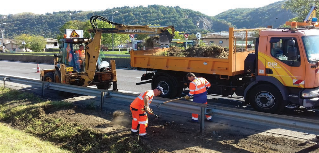
RN7 : Chantier de dérasement sous glissières 2x2 voies au sud de Vienne
