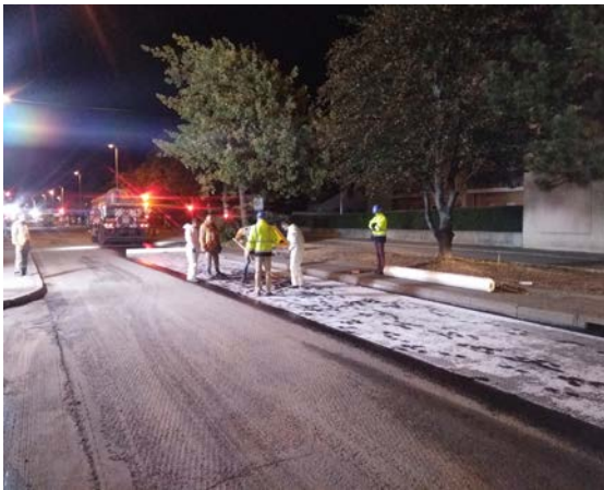
RN7 : Chantier expérimental d'enrobés à Roussillon permettant le renforcement de la structure de la chaussée
