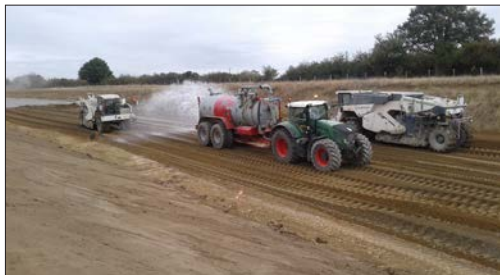
RN7-Villeneuve/Allier Traitement de la couche de forme au liant hydraulique
