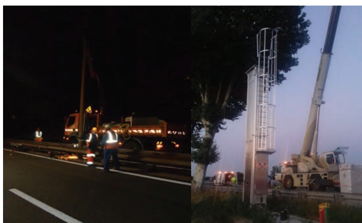
A43 : Démontage des mats d'éclairage public
