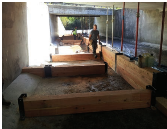
RN90 : Dispositif de franchissement piscicole du radier du pont sur l'Ormente
