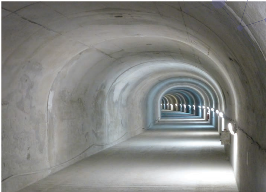
RN 90 : creusement de la galerie de sécurité du tunnel du Siaix (Savoie).
