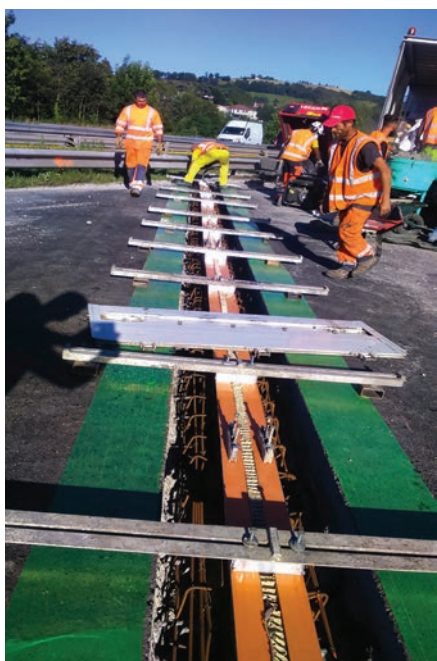
A72 : Travaux de joints de chaussée le 22 juin 2018
