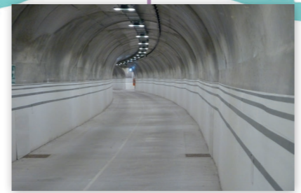
La galerie reste éclairée en permanence (éclairage réduit la nuit).
