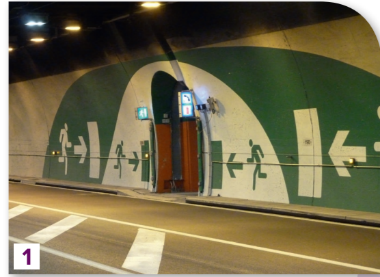
1 En cas d'incident dans le tube routier, donnez l'alerte à partir des niches de sécurité situées de part et d'autre de la chaussée (des extincteurs y sont également à disposition).
