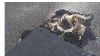
La structure de la chaussée en place depuis 1995, de type rigide en béton, accuse des dégradations importantes pouvant mettre en jeu la sécurité des usagers.
