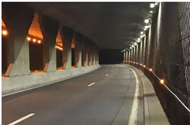
Tranchée couverte Salvador Allende avec sa nouvelle installation d'éclairage et les plots de jalonnement sur le piédroit (à droite).
