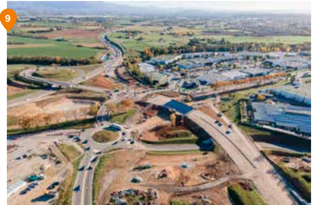
9 Drôme - RN7 - Aménagement du carrefour « Les Couleures » : Terrassement pour une bretelle, coffrage de piles du pont de la RN7, prolongation d'un ouvrage hydraulique
