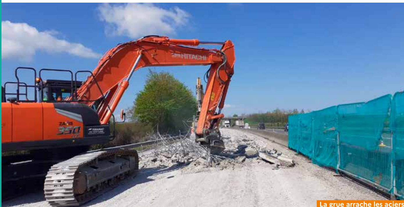
La grue arrache les aciers
