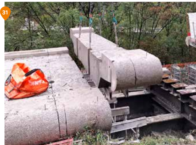
31 Savoie – RN90 – Bretelle du Siboulet : Remplacement de travées
