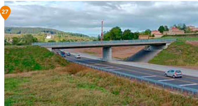
27 Saône-et-Loire - RN79 – Section Brandon Clermain : Mise en circulation du diffuseur de Clermain le 06 décembre
