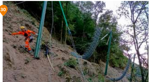
30 Savoie - RN90 - Sécurisation des gorges de Ponserand : Pose d'écrans pare-blocs dans un environnement d'accès difficile avec un hélitreuillage des matériaux
