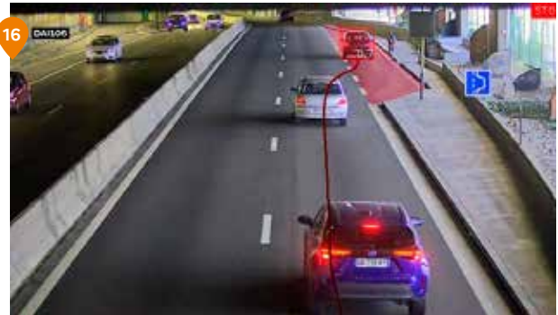
16 Loire - RN88 - Fin de la sécurisation de la tranchée couverte de Firminy : Tunnel en exploitation depuis le 26 juin avec la détection automatique des incidents
