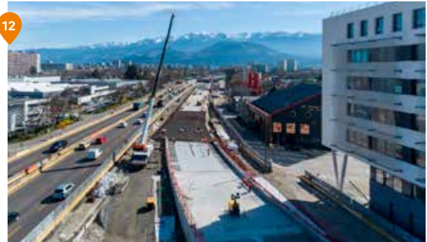
12 Isère - A480 – RN87 - Réaménagement du Rondeau : Réalisation des traverses nord et sud (ferraillage, bétonnage, étanchéité)
