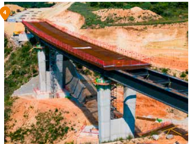
4 Ardèche - RN102 - Contournement de la ville du Teil : Construction des piles du viaduc du Chabassot et poussée de sa charpente métallique
