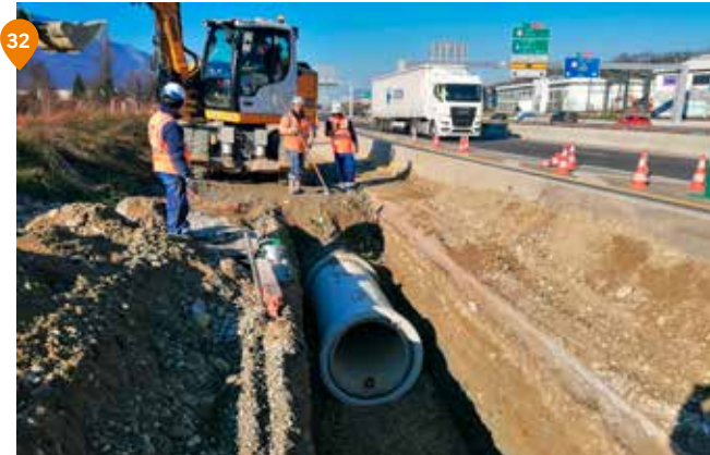
32 Savoie – RN201 – VRU de Chambéry : Pose de canalisations sous circulation
