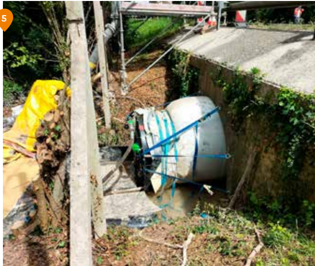
5 Aube - RN77 - Buse de la Tremagne : Technique innovante pour consolider la buse via sa fermeture avec un bouchon le temps que la gaine se fige grâce à des UV
