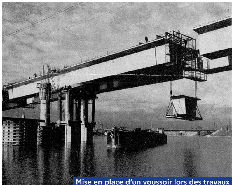
Mise en place d'un voussoir lors des travaux de construction des viaducs de Pierre-Bénite
