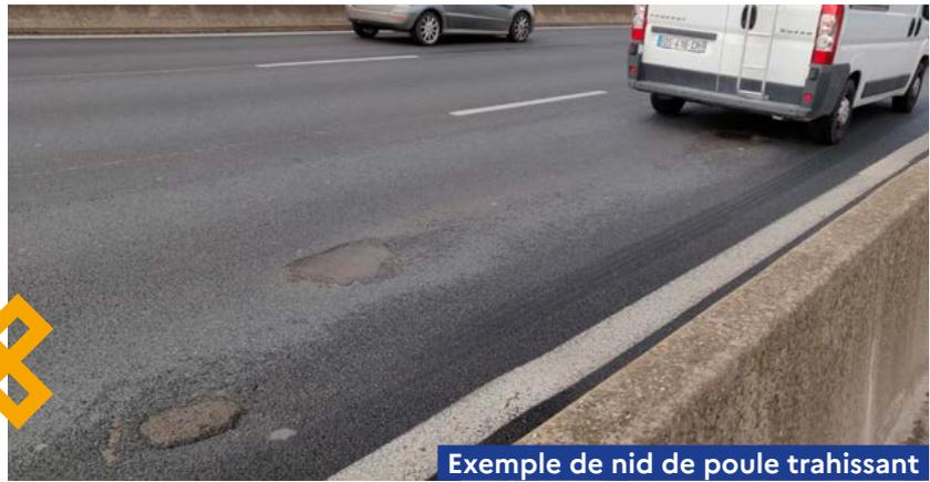
Exemple de nid de poule trahissant la déficience de l'étanchéité de l'ouvrage
