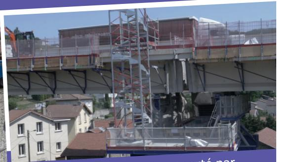
04. Ouvrage entièrement supporté par les structures provisoires
