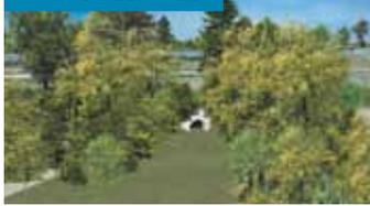
Les entrées du passage ont été conçues de manière à élargir au maximum la surface accessible à la petite faune et seront protégées de tout éclairage. Un dispositif de clôtures est prévu de part et d'autre afin de guider les animaux le long des barrières de la Rocade.
