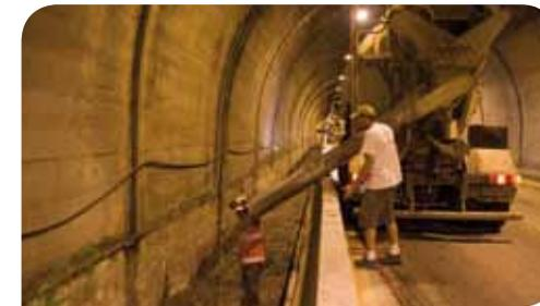
Pose du collecteur d'un diamètre de 300 mm et bétonnage.
