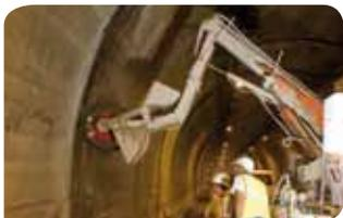
Lors de la construction du tunnel aucune étanchéité n'avait été mise en place. Il est aujourd'hui nécessaire d'y remédier en installant un nouveau profilé de néoprène en forme de demi-cercle sur les joints de construction du tunnel. Il capte ainsi les eaux et les évacue.
