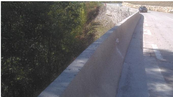
▼ RN90 / Remplacement de caniveaux à grille par des caniveaux à fente
