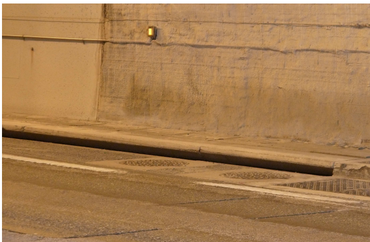
Exemple de caniveau à fente
