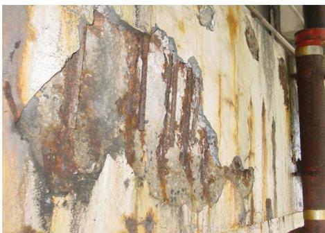
Dégradation du béton situé sur la partie supérieure d'un pilier de l'ouvrage.
