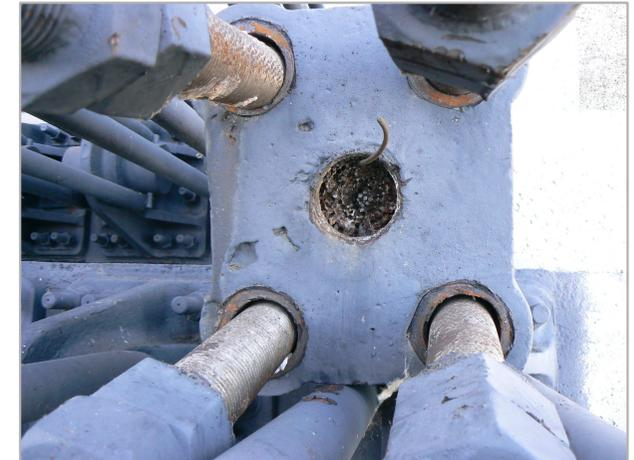
*Corrosion sur le câble rompu*
