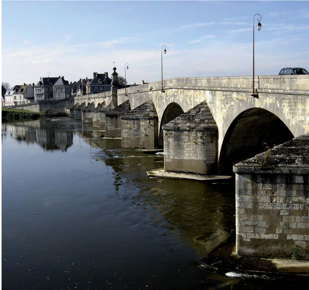
Vue de l'ouvrage côté amont depuis La Charité sur Loire
