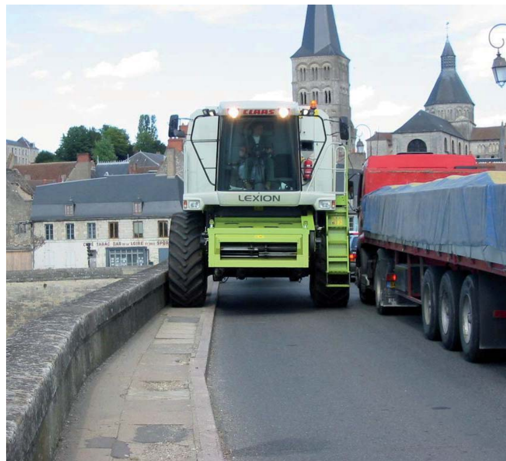
Croisement de deux véhicules lourds sur l'ouvrage
