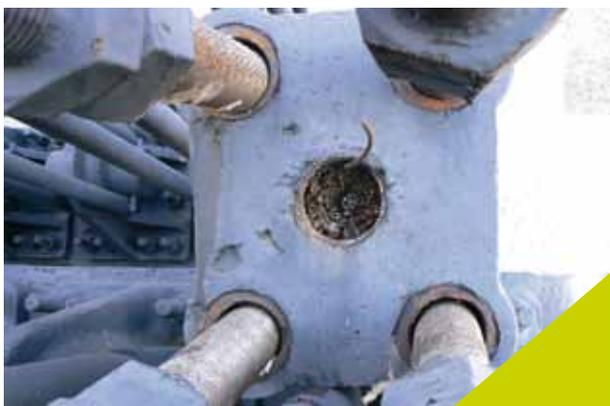
Corrosion sur le câble rompu
