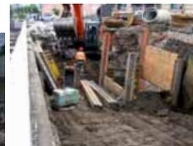
Une fois les profilés insérés, le creusement de l'espace est réalisé à l'aide d'une pelleuse et d'un brise-roche hydraulique.
