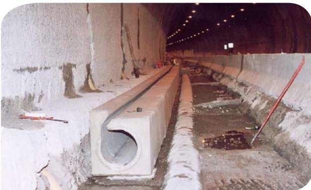
Exemple de mise en place des réseaux d'assainissement et d'un caniveau à fente
