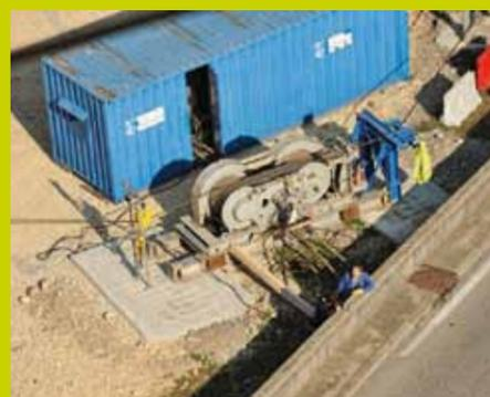
Le treuil installé en rive droite dirige le câble de traction.
