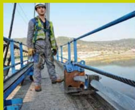
Le câble de traction tire le câble neuf le long de la passerelle provisoire.
