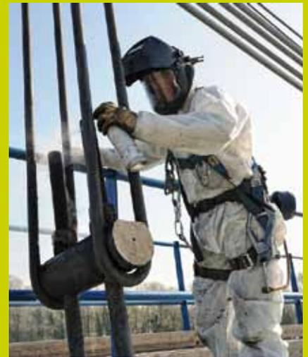
Application de dégrissant après brûlage de la peinture pour permettre le desserrage des écrous.
