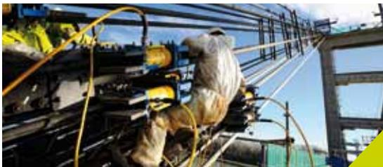
Étape 1 : Tension des câbles pour lever le pont
